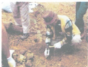
階段の固定、岩部分に留意して打ち込み
