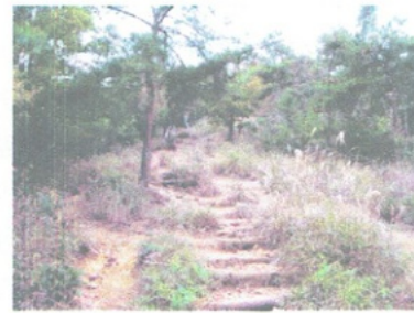
階段損傷部(整備前)
