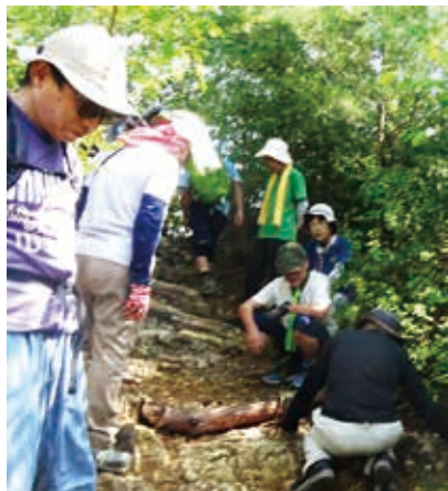
階段補修作業を行う会員
