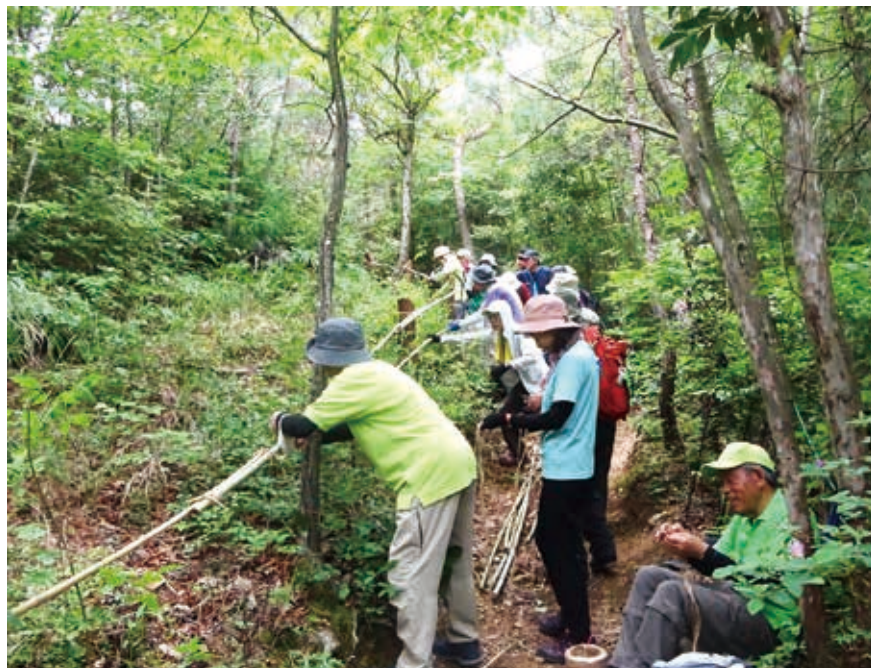
柵の補修作業中
