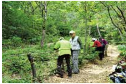
柵の設置作業
