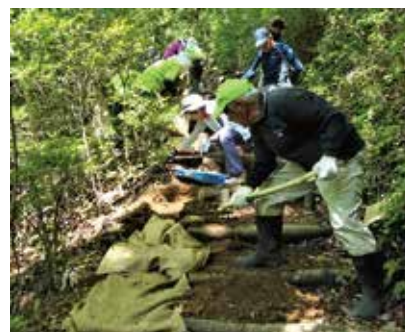
大脇ルートの土のう交換作業
