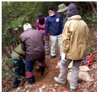
古い土のうを掘り出し、新しい土のうを設置
