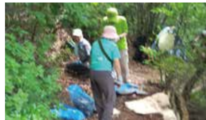
土のうの据え替えは重労働だ
