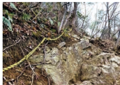
トラロープ設置
