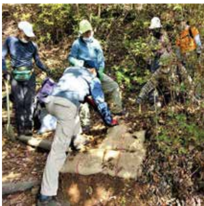
麻袋の土のうを設置する
