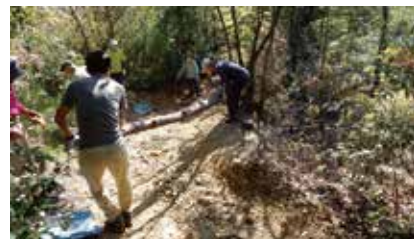
大きくえぐられた登山道を間伐材を使い補修する
