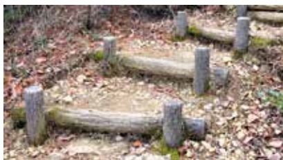
縦の擬木が出ている様子
