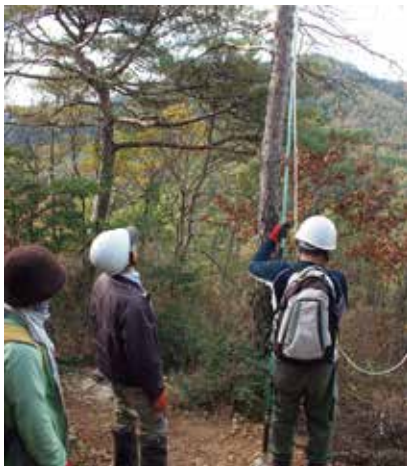
ロープで伐倒方向を調節し安全に作業を行う
